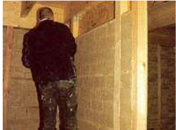
Quelle: LehmBauWerk Berlin
